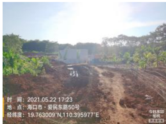
建设中的污水处理厂
