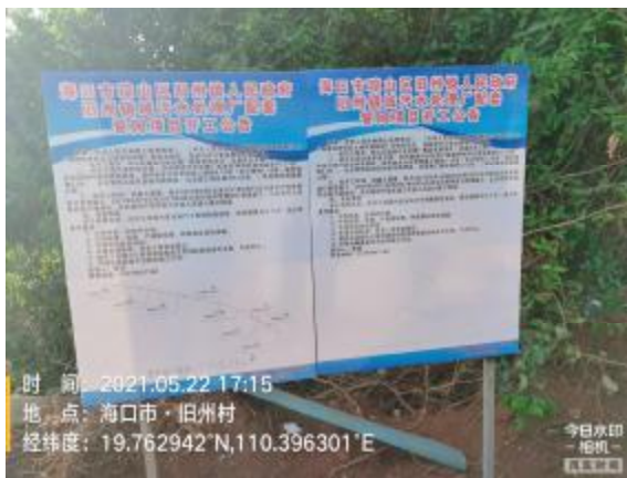
污水处理厂已开工建设
