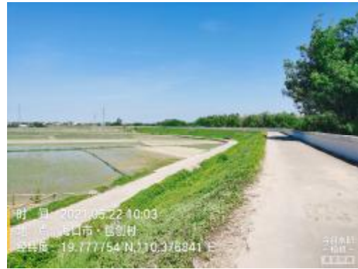
堤坝左侧（外侧）
