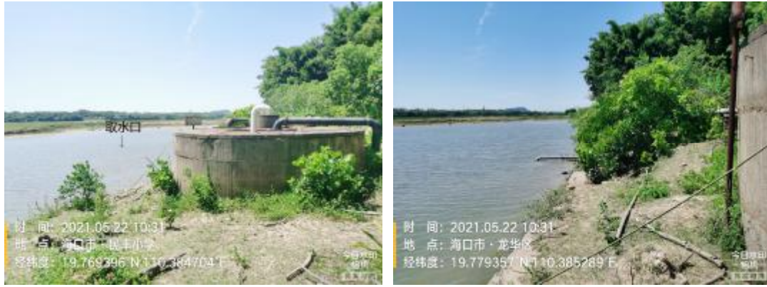
图 2-6 水源地取水口
